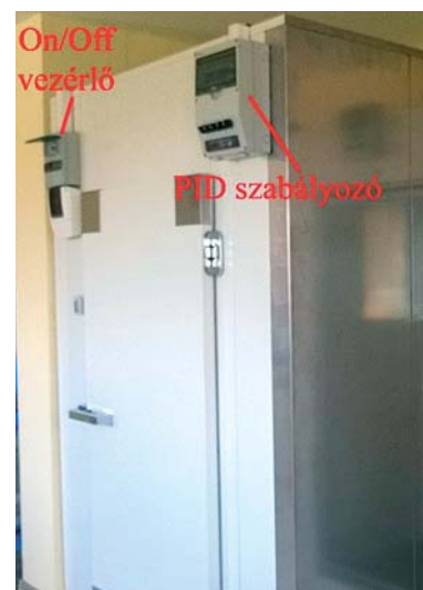
3. ábra. Az alkalmazott szabályozó egységek a kísérleti tesztkamrán
