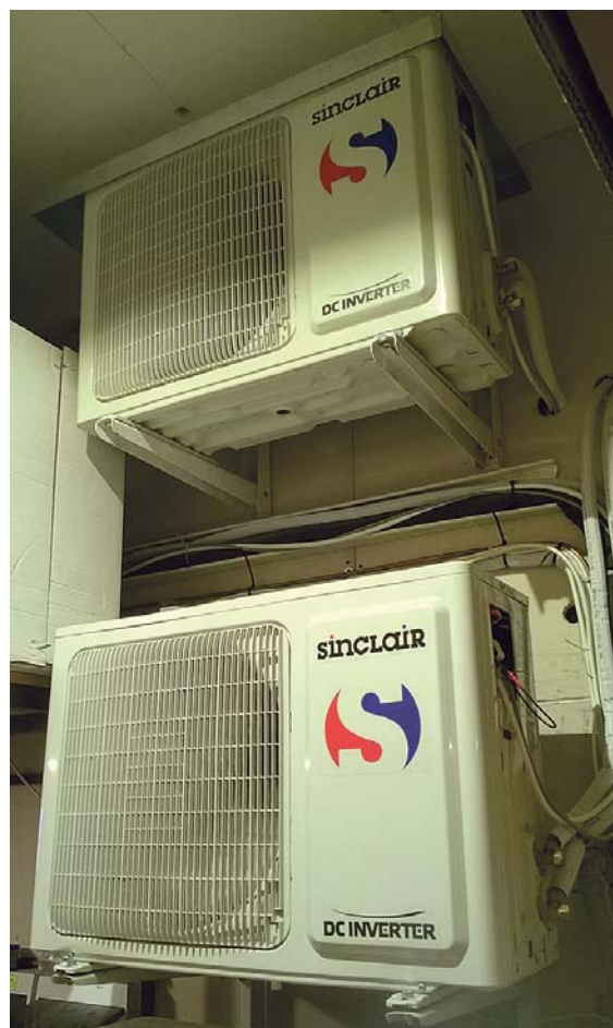
6. ábra. A külső egységek (a felső a fűtési, az alsó a hűtési funkciót biztosítja)
